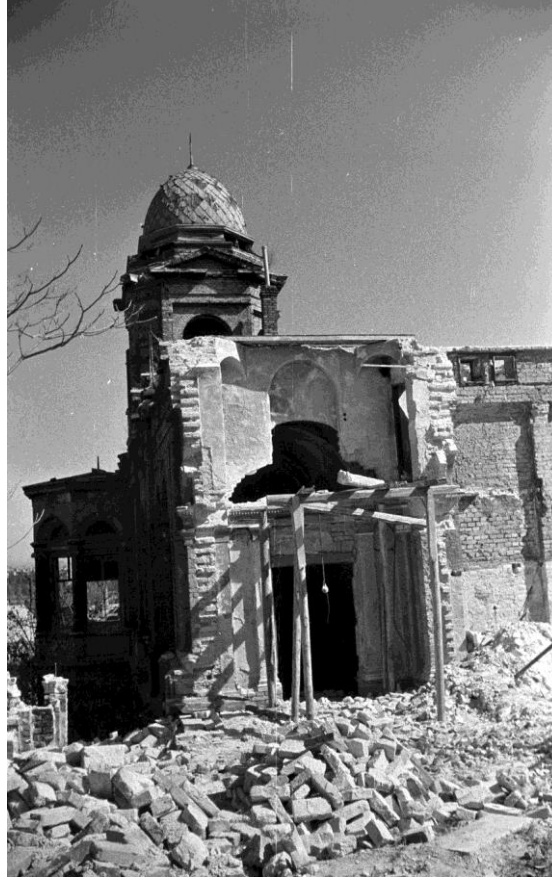
Şekil 9. Wagner Villası'nın yıkılmış bölümü. 1971. (Fotoğraf: Fortepan - Géza Kriss, no. 193346)
