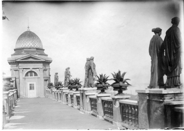
Şekil 14. Wagner Villası'nın çatı kat terasının Tuna Nehri tarafındaki korkuluğu ve heykelleri. (Fotoğraf: András Bánhidý Aile Arşivi)
