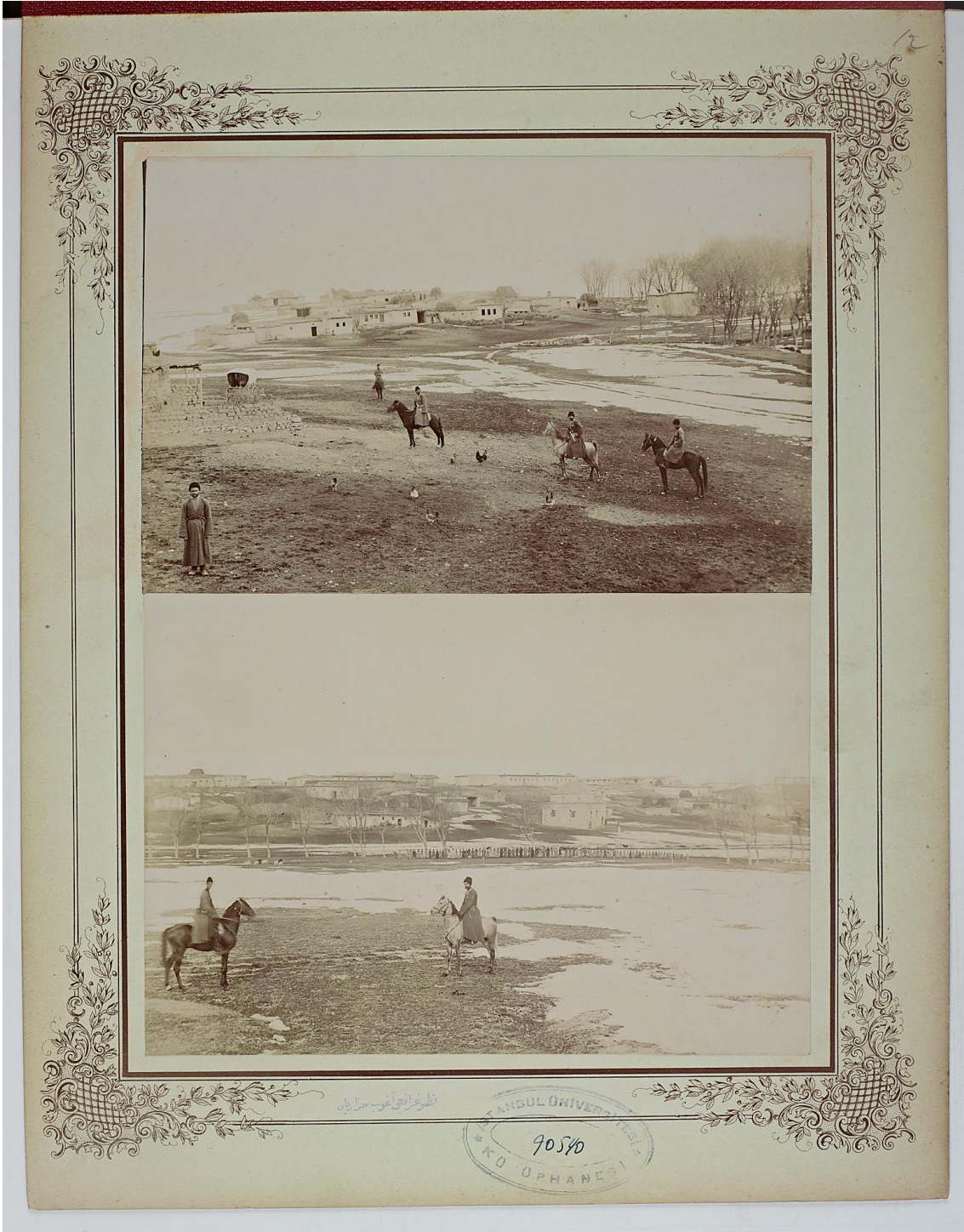
Resim.1 Yozgat'a bağlı Poyrazlı köyünde iskân edilen muhacirler 68
